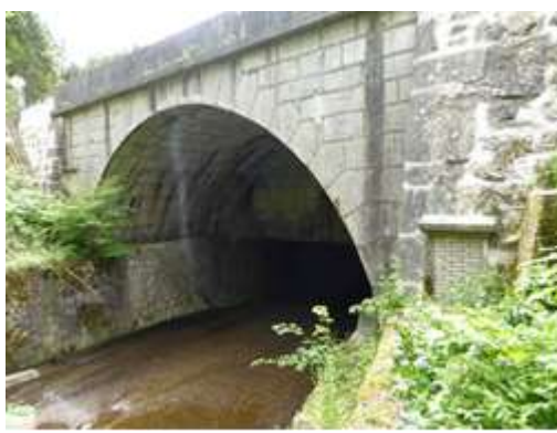
Ouvrage M 0196 sous le Pont sur le Seyon
